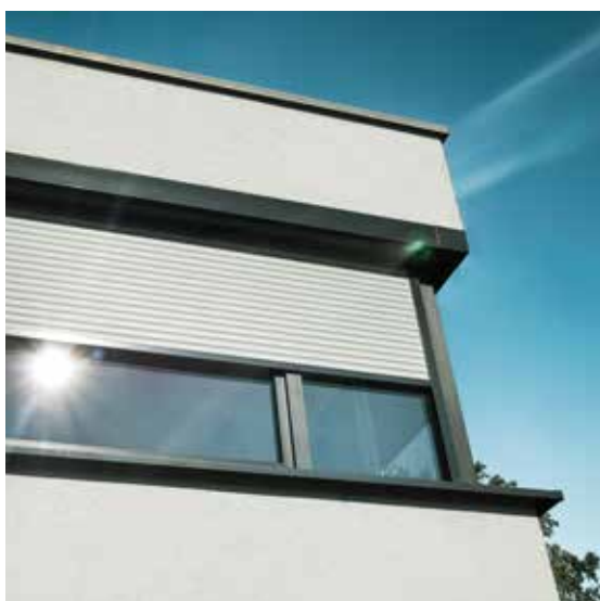
Vorbaurollladen QUADRO flächenbündig mit der Fassade montiert.
