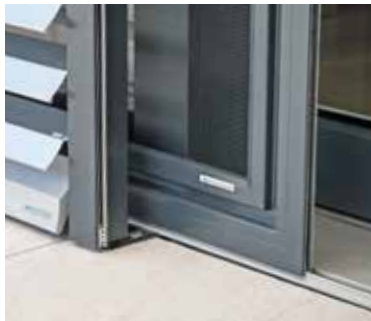
Freitragende Führungsschiene für Insektenschutz Schieberahmen
