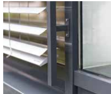
Führungsschiene mit Abstandhalter
